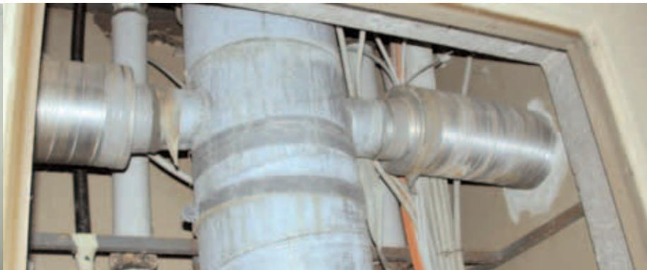
Abb. 3: Versorgungsschacht, der eine feuerbeständige (F 90) Abtrennung zu den angrenzenden Nutzungseinheiten aufweisen sollte.
