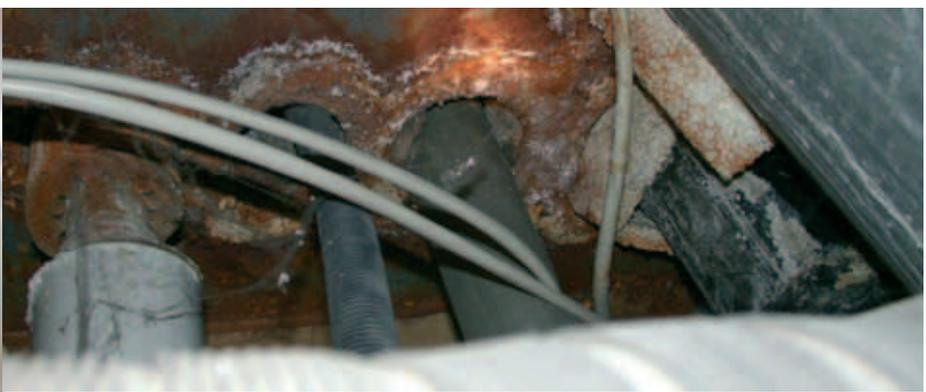
Abb. 5: Detail aus Abb. 3 bzgl. der „feuerbeständigen Abschottung“ im Deckenbereich mit Styropor. Diese Ausführung ist selbsterklärend.
