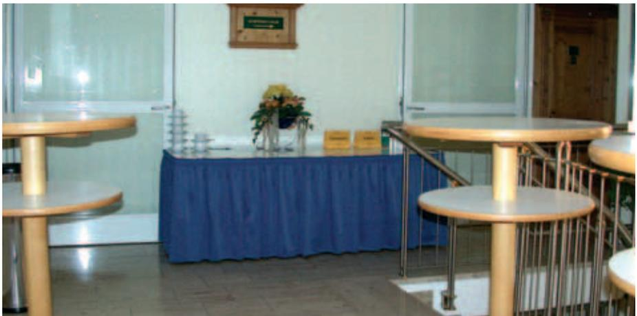
Abb. 6: Notwendiges Treppenhaus an oberster Stelle mit angrenzenden Nutzungseinheiten. Die beiden selbstschließenden Rauchschutztüren sind mittels einer „stärkeren Feststelleinrichtung“ (Tisch) im Gefahrenfall funktionslos.
