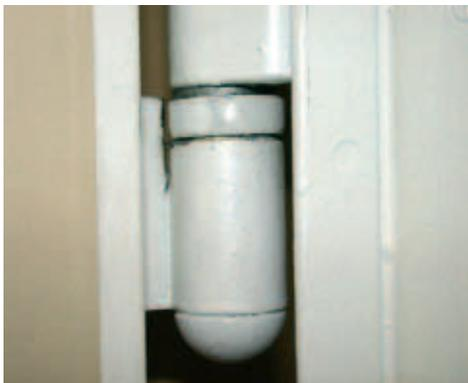
Abb. 2: T90-Brandschutztür mit gekürztem Band, die deshalb im Brandfall keine 90 Minuten Brandbeanspruchung mehr standhalten wird.
