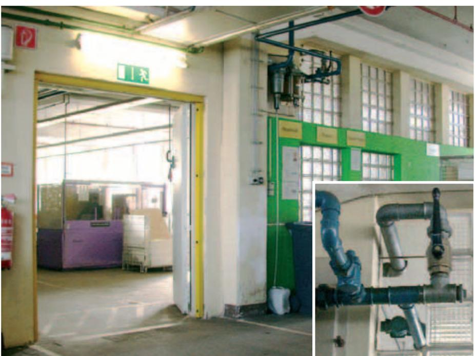
Abb. 7: Neu eingebaute Brandschutztür T30. Warum eine neue Brandschutztür, wenn gem. Abb. 8 kein brandschutztechnischer Abschluss gewährleistet ist?
