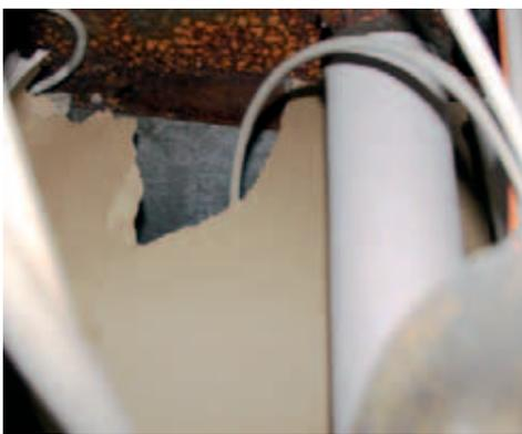
Abb. 4: Detail aus Abb. 3 bzgl. der „feuerbeständigen Abtrennung“ zu einer Nutzungseinheit.
